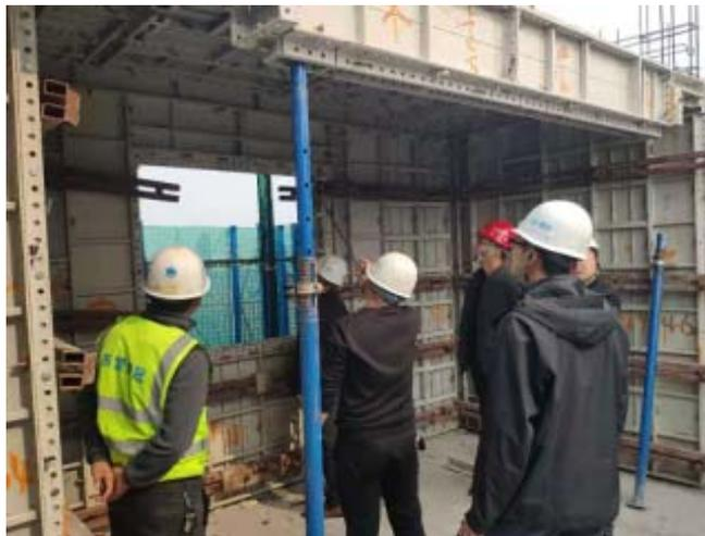
图4 调校墙柱模板
