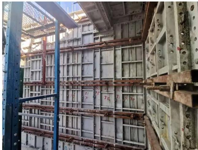
图2 外剪力墙铝模墙身采用五排背楞
