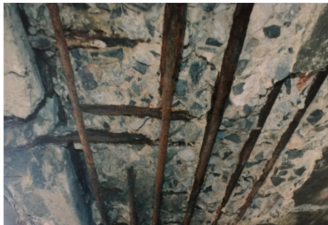
图2 钢筋腐蚀
