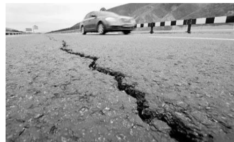
图1 桥面开裂
