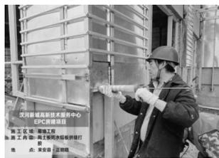
图4 防水铝板拼缝打胶
