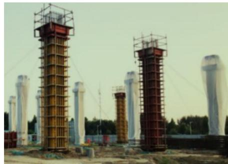
图 3 带柱帽原位现浇柱
