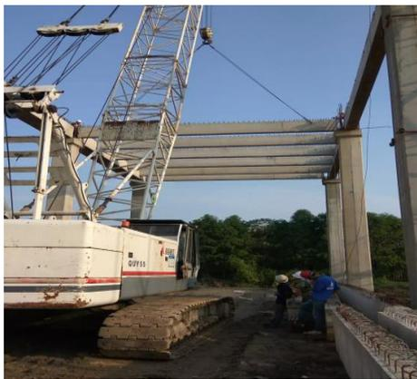
图5 预制预应力次梁吊装
