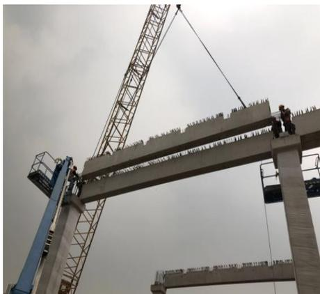
图4 预制预应力主梁吊装
