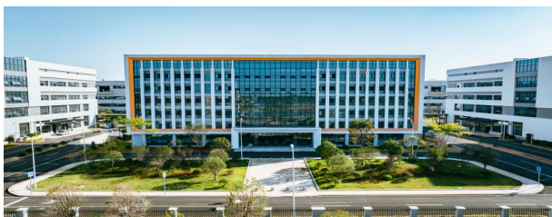
图2：道路绿化设计（长沙5G智能终端产业园项目实景图）
