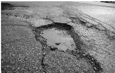
图一：路面材料缺陷导致出现坑洼
