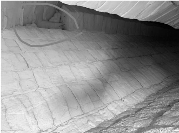
图7 “Z”字段上方模块脱落
