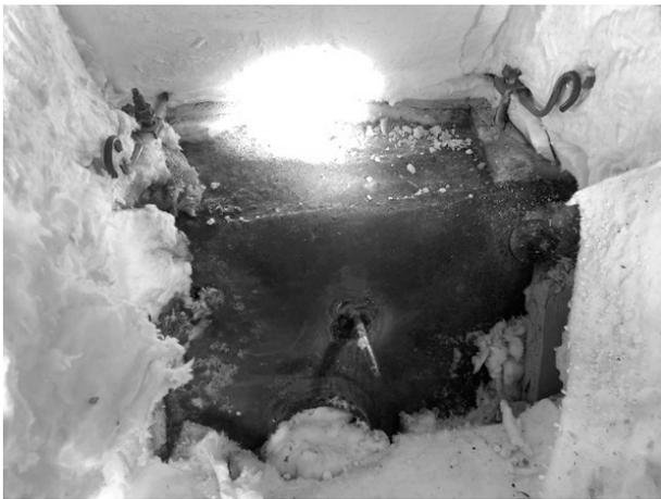
图8 管孔处模块固定不牢
