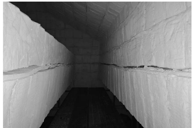
图5 拐角模块缝隙
