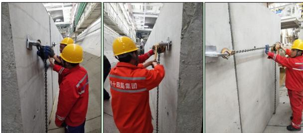
图9 中箱涵附属拉紧装置示意图
