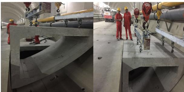
图10 扁担梁拼装边箱涵示意图
