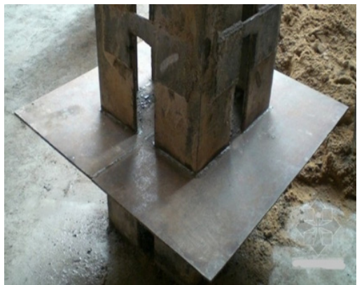
图 13 格构柱与底板防渗装置
