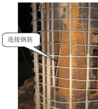
图10 格构柱钢筋笼定位示意图
