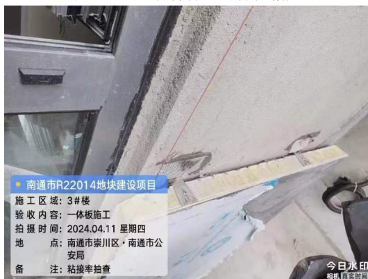
图 4.2.6-1 岩棉保温一体板锚固及防水节点
