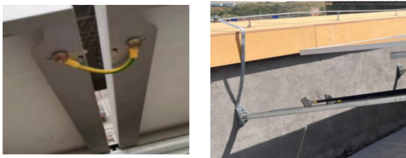
图1 等电位连接与接地
