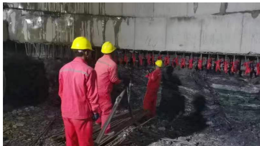
图3 钻孔、锚杆施工
