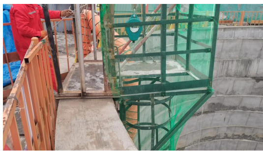
图6 钢直梯安装示意图
