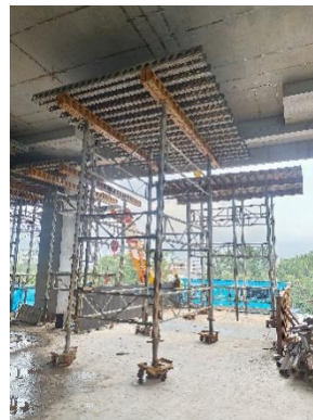
图8 台模实施拆模后待周转状态
