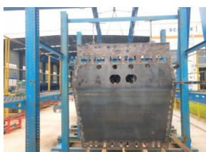
a. 湿接缝端头板安装
