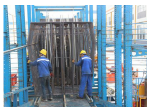
b. 箍筋安装
