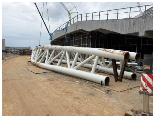
图2 工厂卧式预拼装现场图
