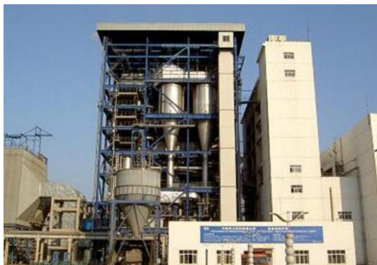
图 1 300MW 循环流化床锅炉
