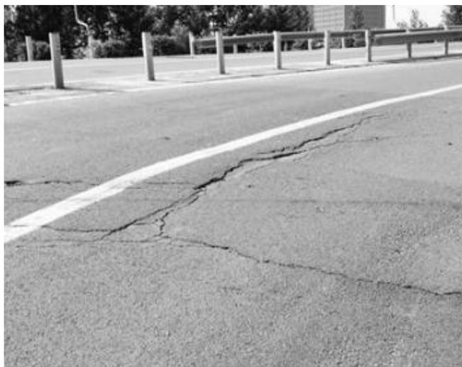
图一 路面裂缝
