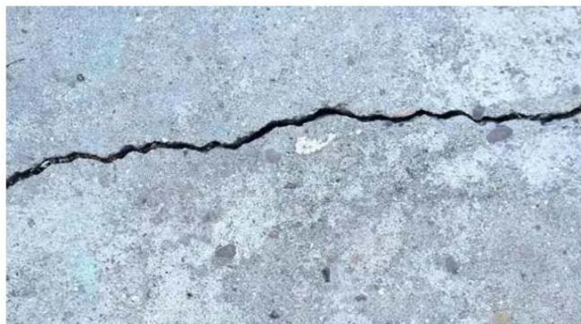
图2 化学反应及荷载作用因素出现的施工裂缝
