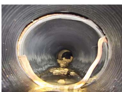
接口胶圈脱落
