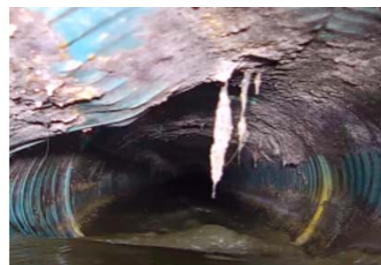
管顶腐蚀
