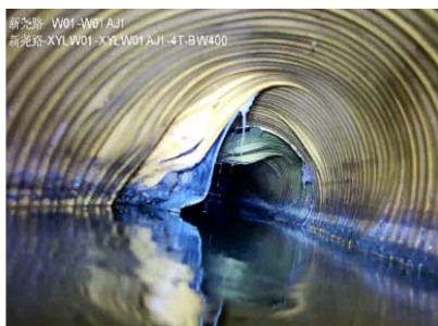
管壁破裂
