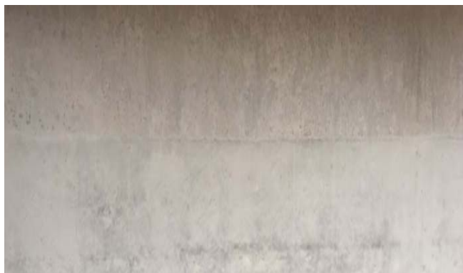
图4 安公高速3标T梁层印问题
