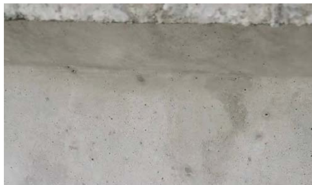
图2 安公高速3标T梁麻面问题
