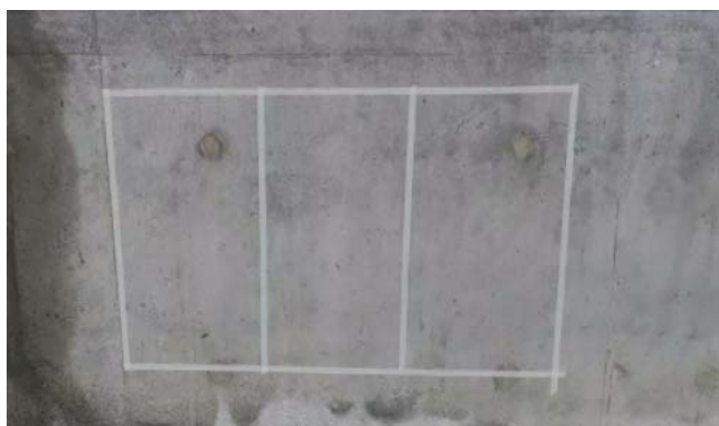
图5 安公高速3标T梁色差问题
