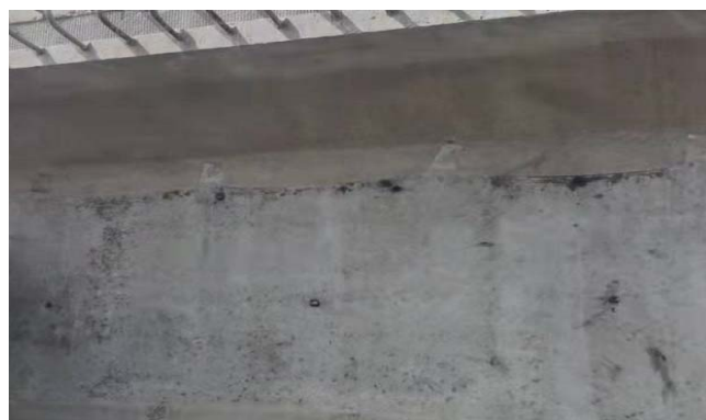
图3 安公高速3标T梁蜂窝问题
