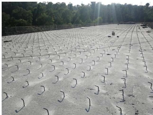
图3 现浇桥面植筋
