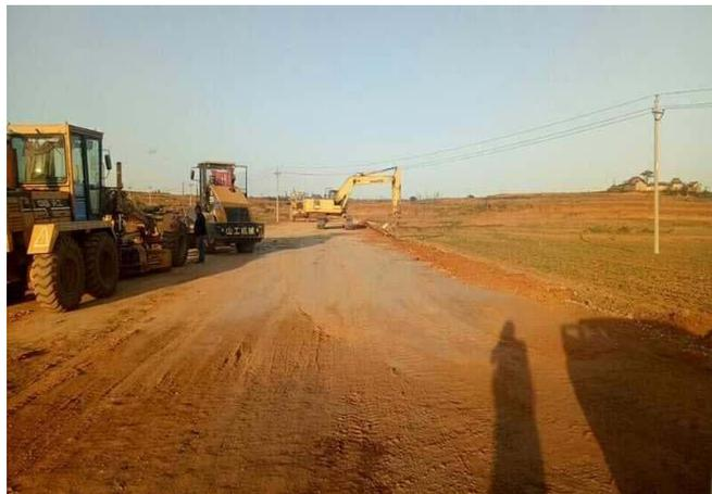
图1 路基路面中的填筑施工
