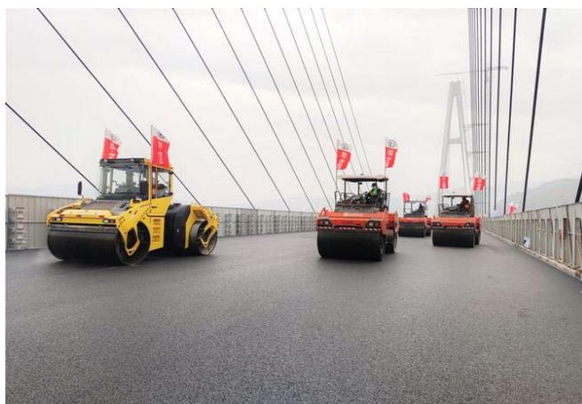
图2 压路机碾压路面
