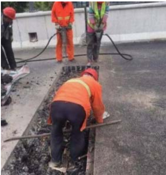
图二 桥梁伸缩缝施工
