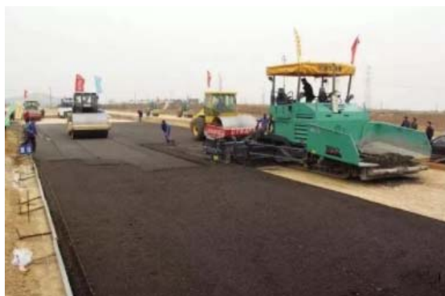
图一 路桥工程施工
