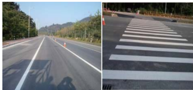
图3 双组份标线施工后的现场
