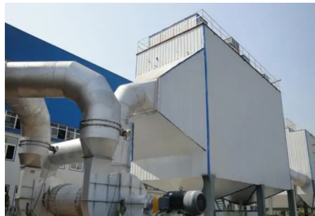
图1: 静电除尘器
