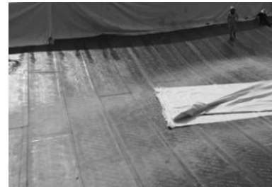
图 1 防水层铺设图
