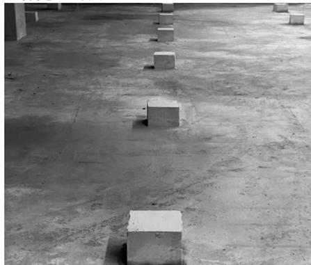
图12 锚杆顶部封堵成品实图
