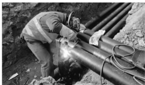
图2 市政工程地下管线施工
