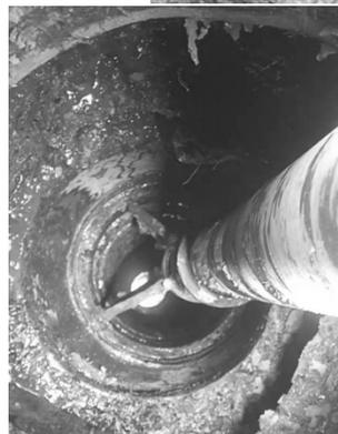
3月1日, 引鱼顶, 下 $\Phi 270\text{mm}$ 套铣头+ $\Phi 193.7\text{mm}$ 套铣管13根+ $\Phi 88.9\text{mm}$ 钻杆4根, H: 188.39m, 188.39-190.89m,  $\Delta h$ : 2.50m。
