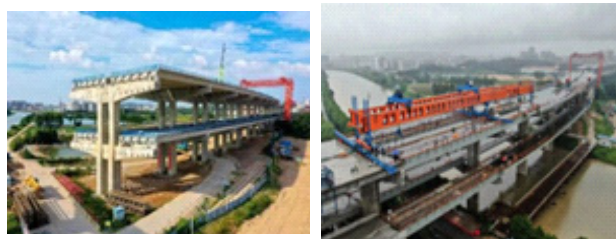
图4 目前正在建的寒溪河双层桥梁
