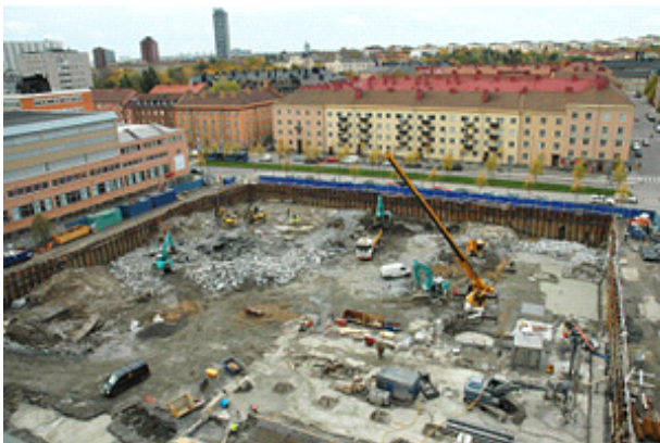
地基处理现场
