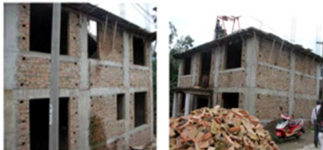
图3 圈梁过度设置
