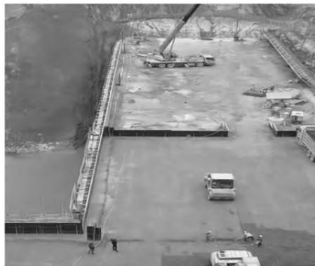
图5 混凝土铺筑碾压
