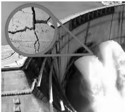
图1 大坝混凝土结构裂缝
