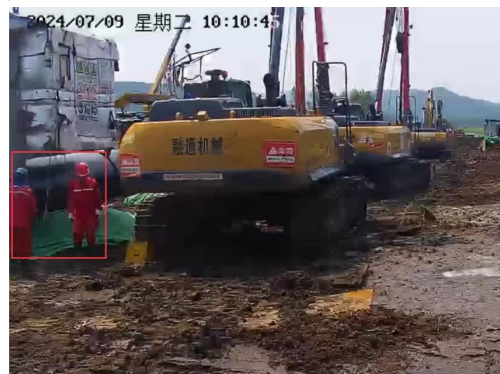
图1 一名作业人员在吊物坠落半径内走动
