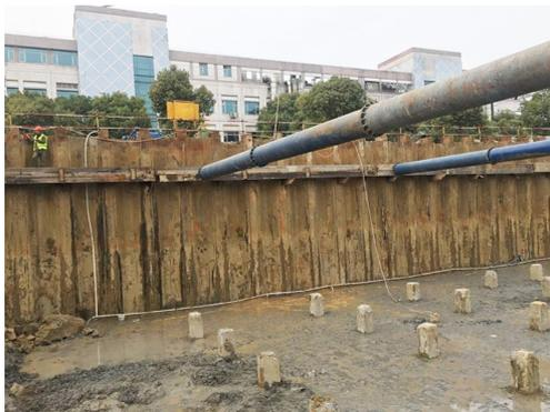
图1 深基坑支护
