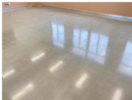
图 4.2.25 干布式无机磨石地面成品效果
