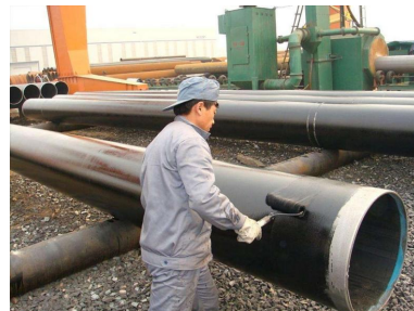
图3 管道外防腐补口
