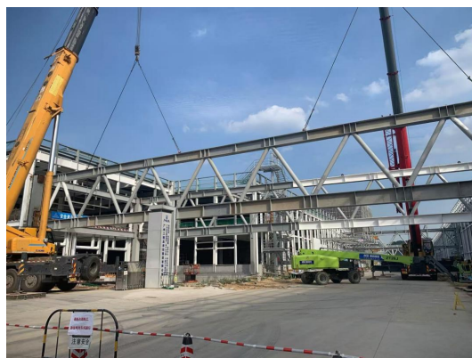
使用2台120t吊车同步起吊
