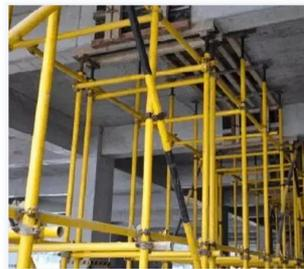
图2 后浇带重新支模后的现场效果图
