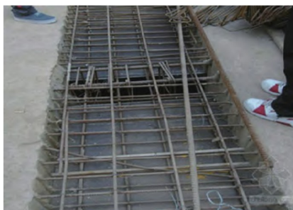
图2 后浇带模板
