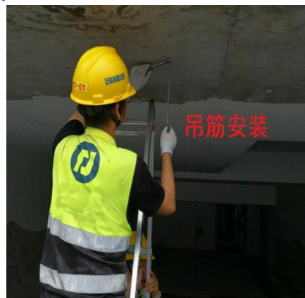
图9 吊筋安装
