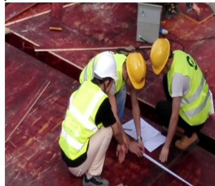
图5 按BIM深化图现场定位
