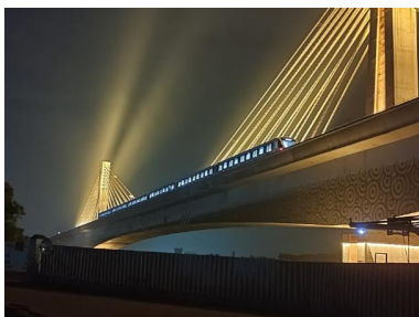
图3 主桥荷载试验照片
