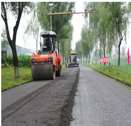
图 2、3 泡沫沥青厂拌冷再生碾压作业示意图
