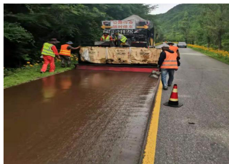
图1 改性稀浆封层铺筑试验段施工图
