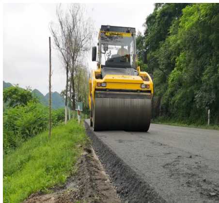
图 2、3 泡沫沥青厂拌冷再生碾压作业示意图
