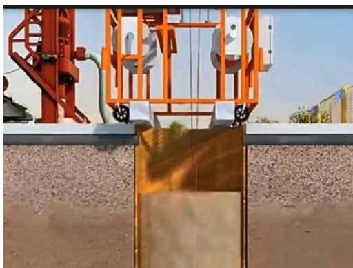
图1 钻孔灌注桩
